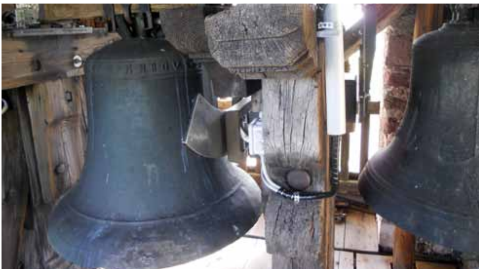
Dieses Bild zeigt das neue Läutwerk
